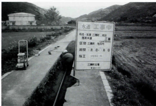
簡易水道工事（上地区）
