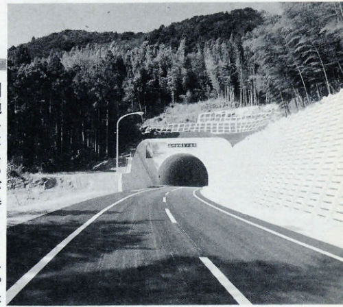
開通したみのが峠トンネル。宇津賀地区の活性化にはずみがつくものと期待される。
