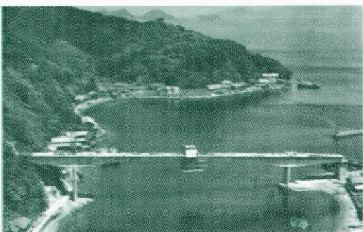
▲ 工事中の青海大橋（昭和40年10月完成）
