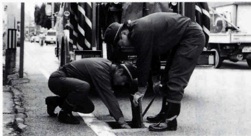
(消火栓・防火水槽は定期的に点検しています)
